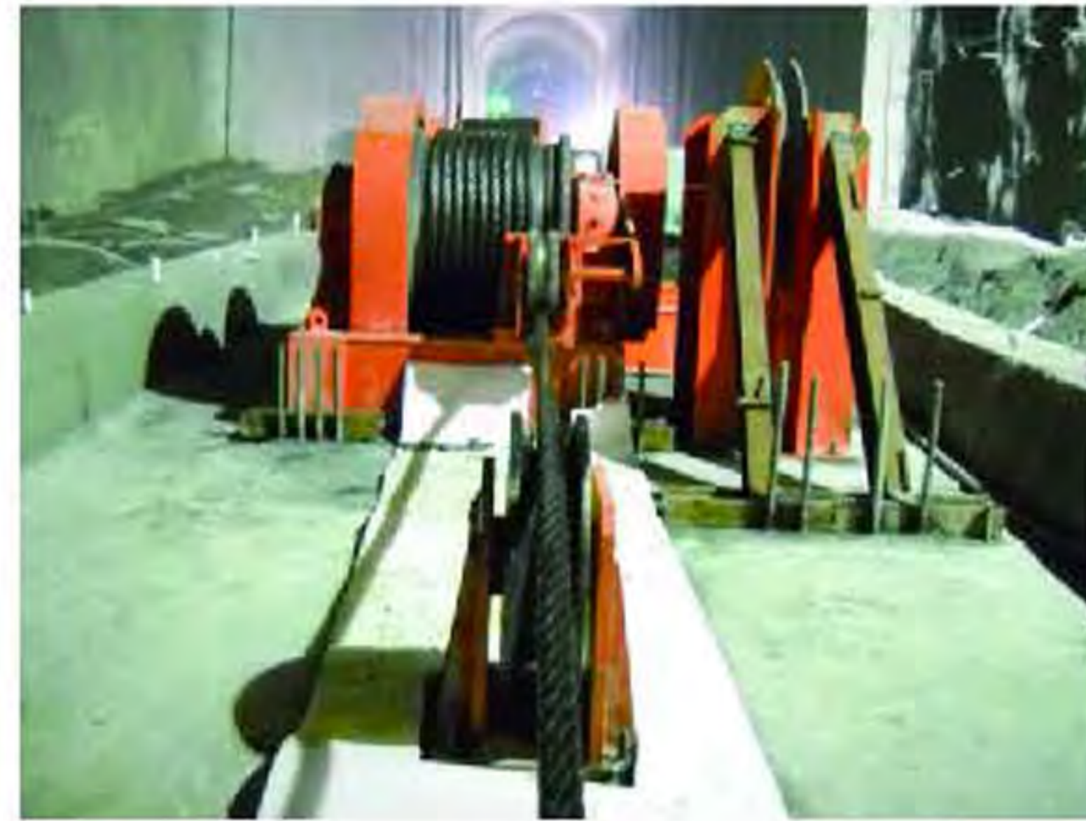
溪洛渡施工现场
