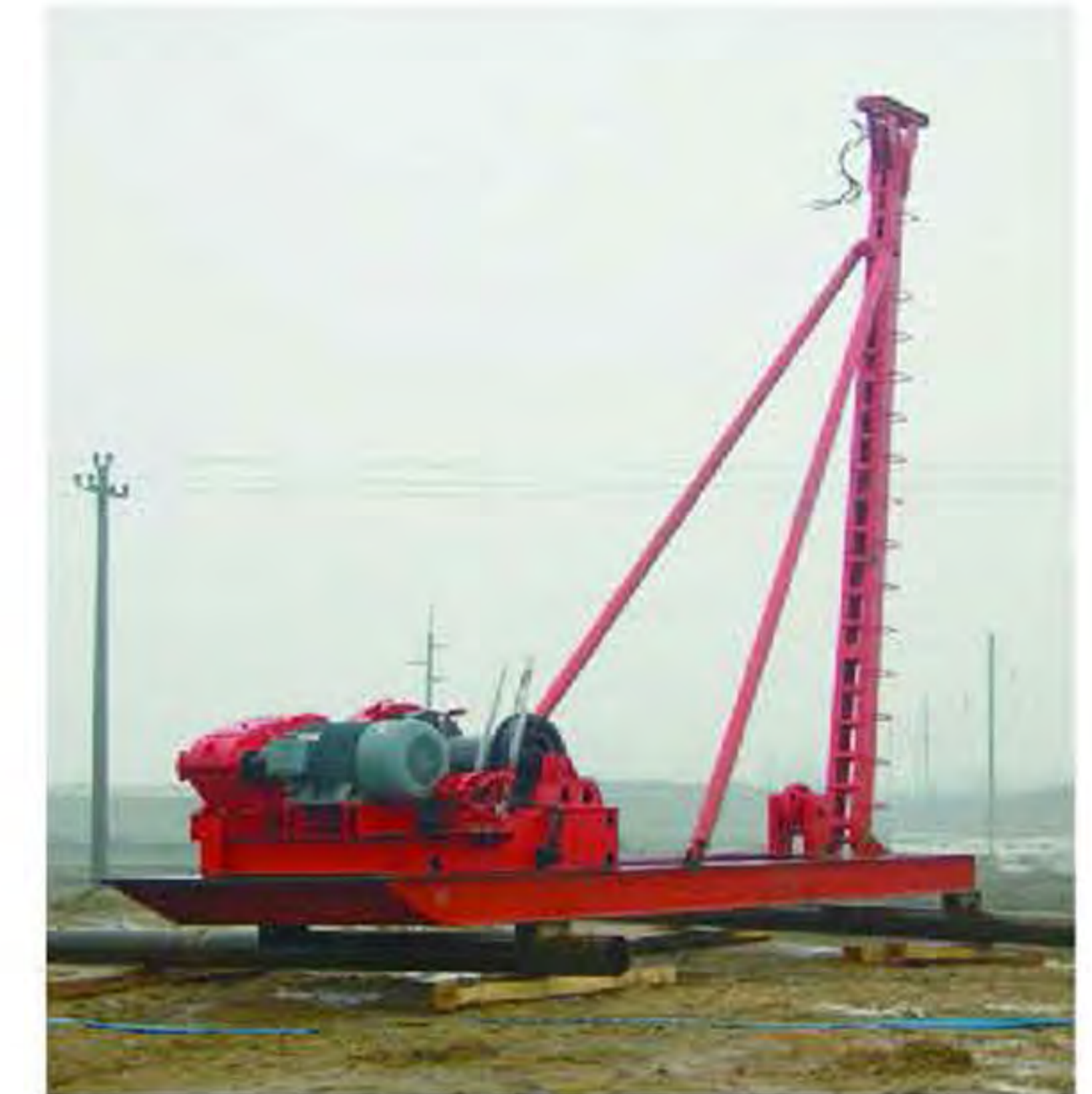
钻机配套卷扬机施工现场
