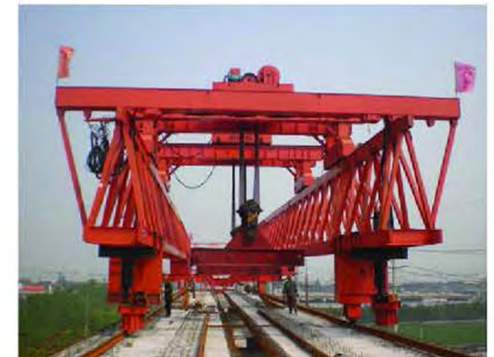
中铁一局施工现场
