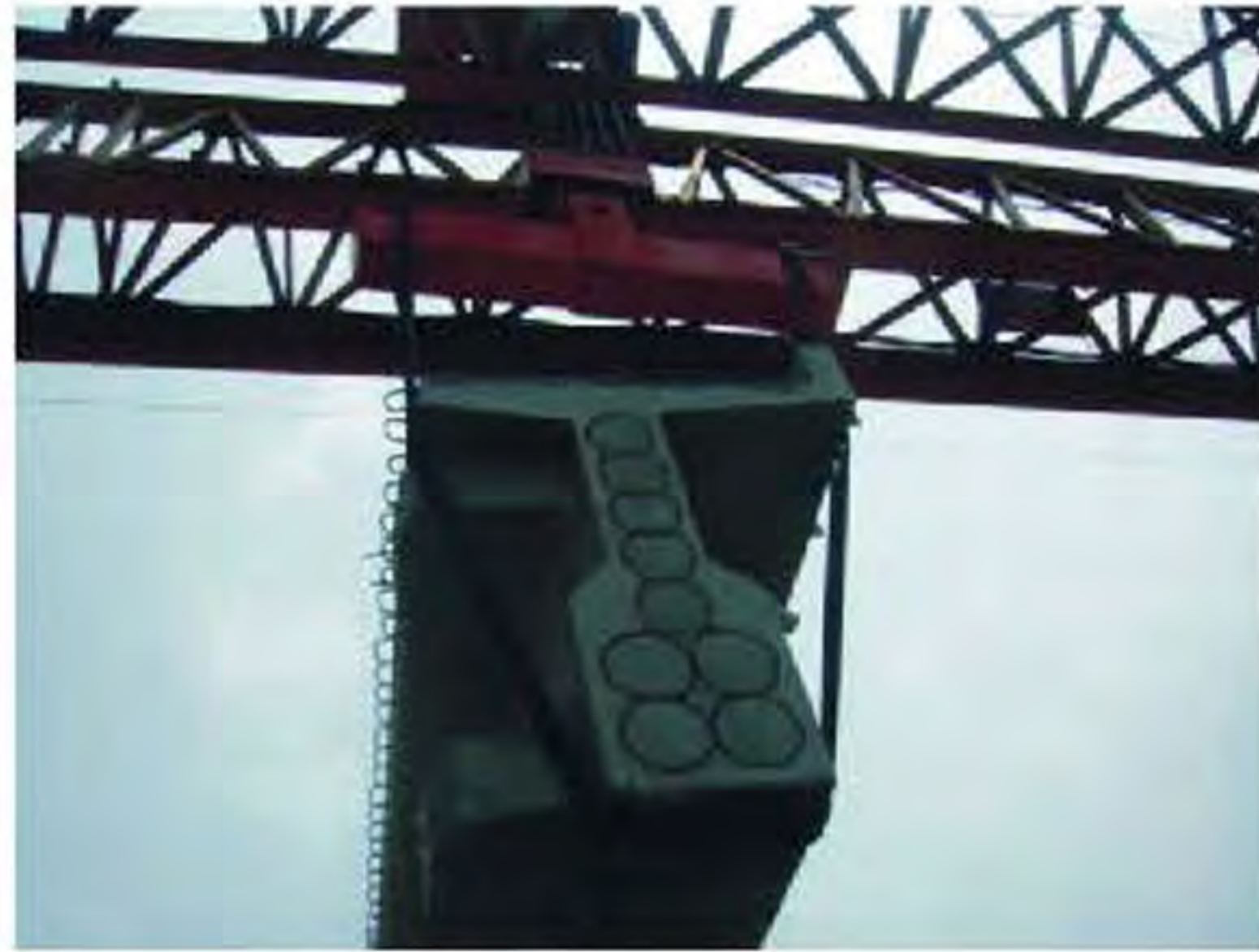
80t小车施工现场
