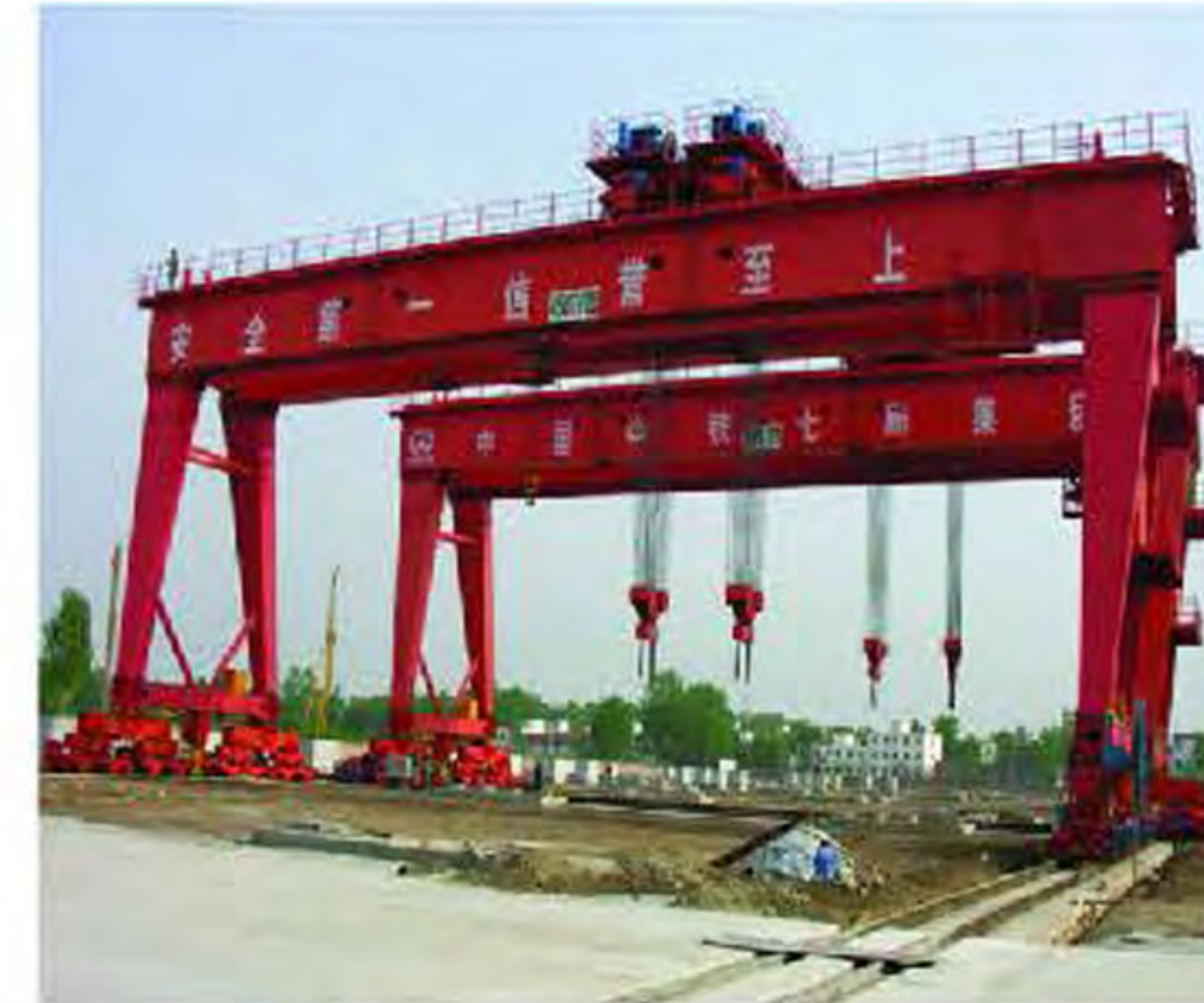
中铁七局施工现场
