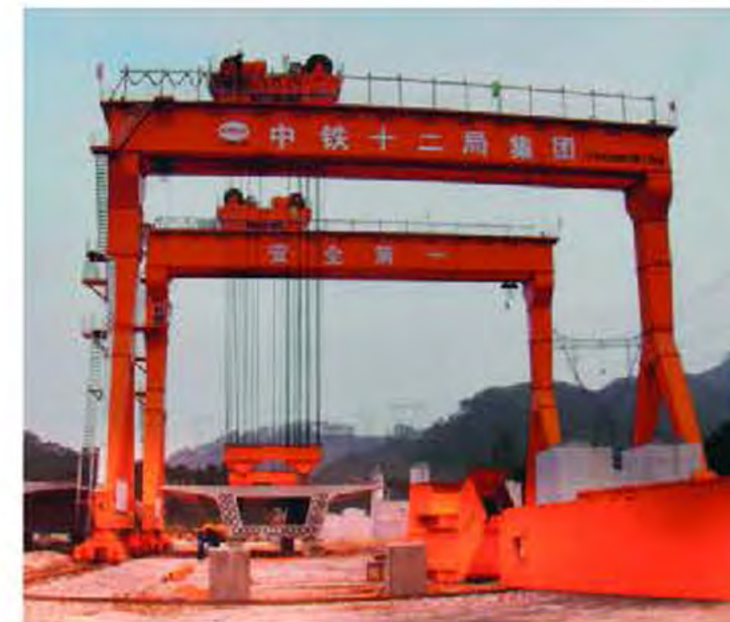
中铁十二局施工现场
