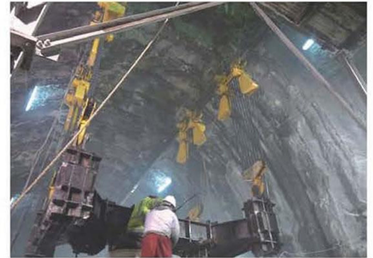
世界500强-意大利CMC100t工程 Fortune 500-ITA CMC 100t Project
